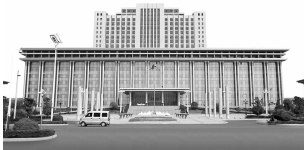
新区办公大楼
